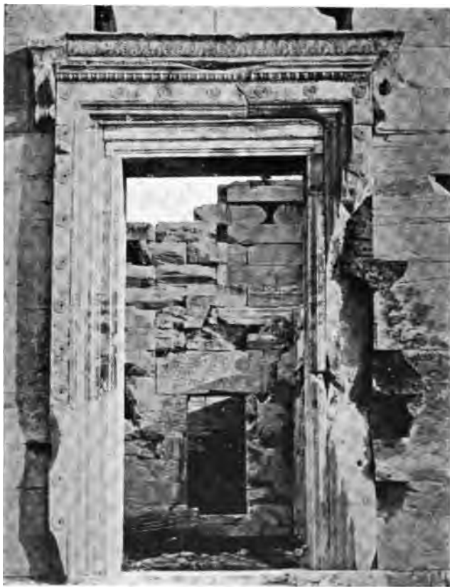
Fig. 55. — Porte sous le portique « prostasis » nord de l'Erechthéon. Chambranle des piédroits retourné de même largeur sur le linteau. Ornaments rapportés dans ce chambranle.
